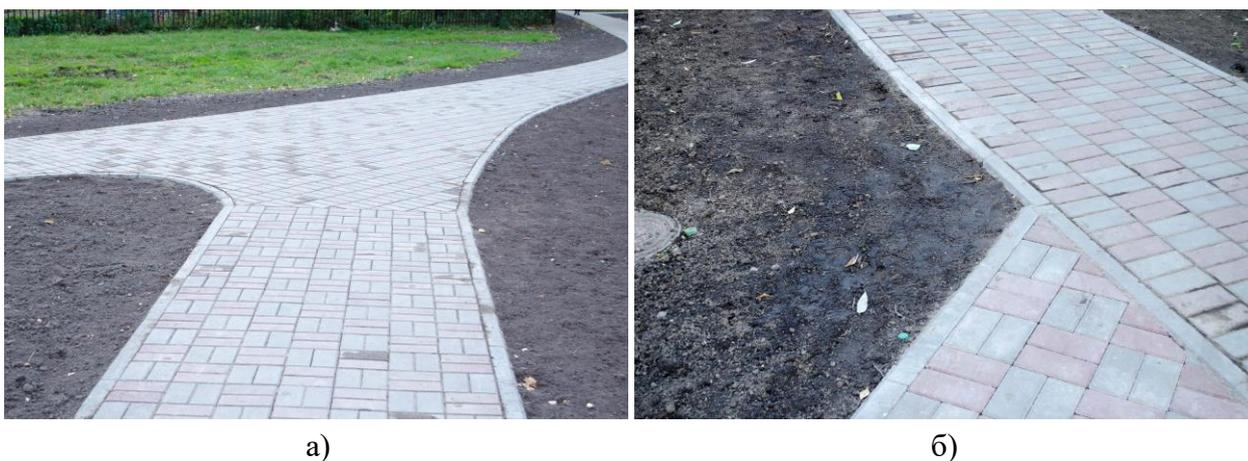
*Рисунок 34. а) правильно выполненное пересечение дорожек; б) неправильно выполненное примыкание дорожки без закругления. Видно, что земля в месте примыкания вытоптана и содержит отпечатки обуви*
