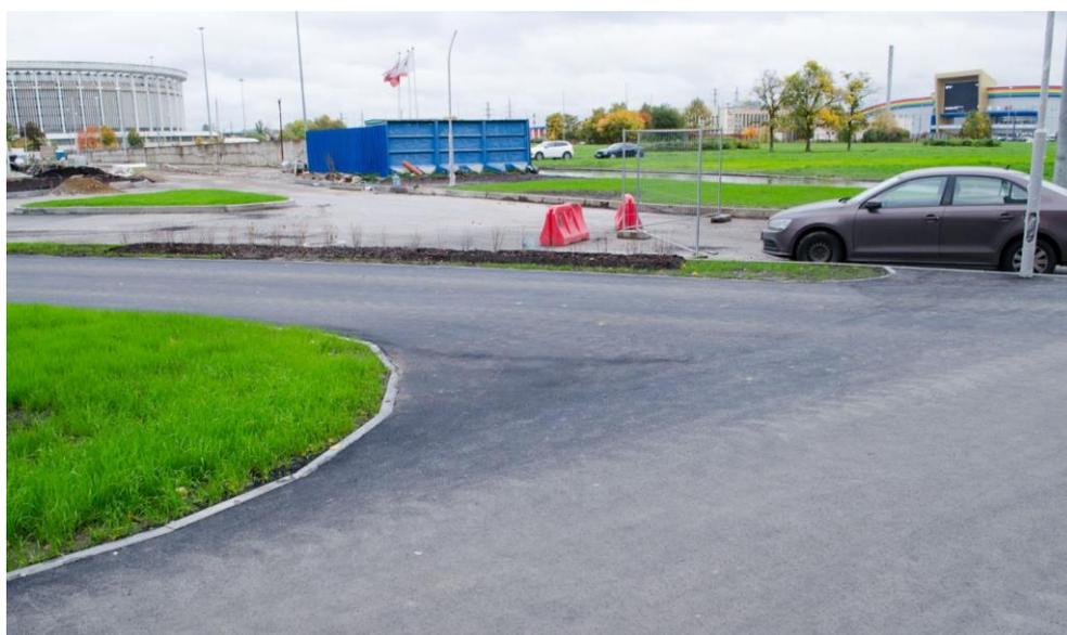
*Рисунок 42. Скругление острого угла*
